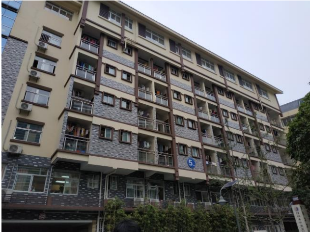
骨伤大楼全景
